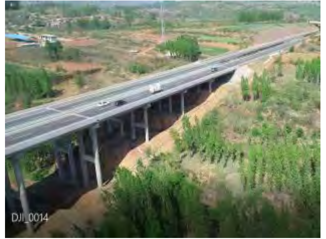
照片 14 龙潭沟大桥
