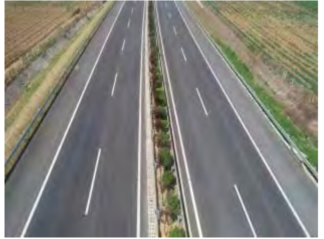
照片 8 路基中央分隔带绿化
