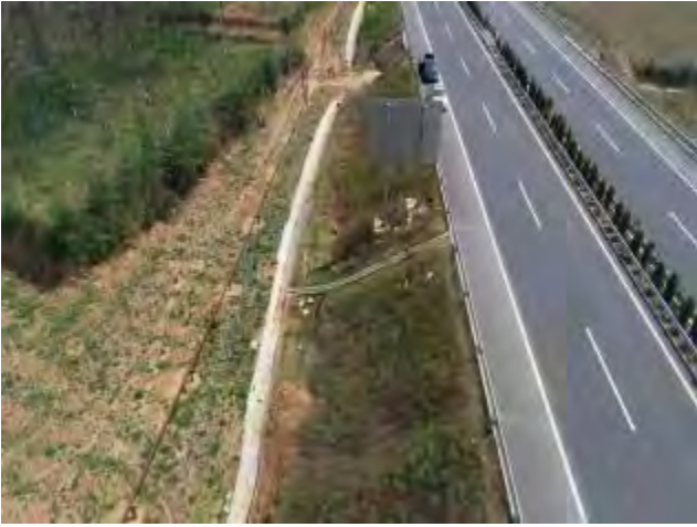
照片 7 路基边坡急流槽
