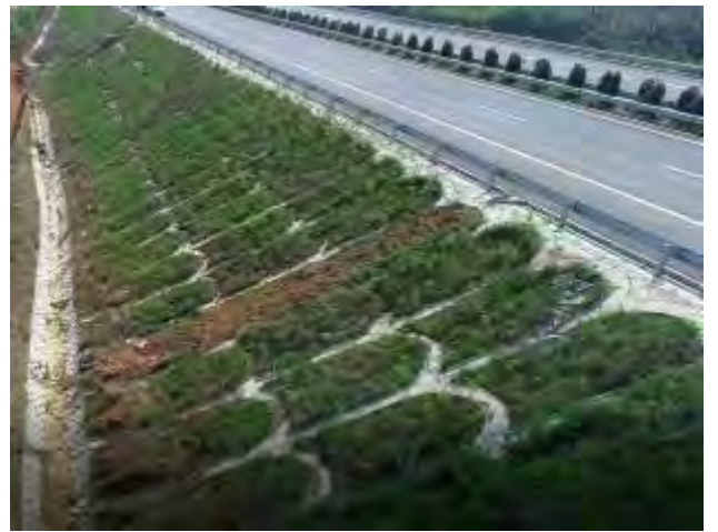
照片 10 拱形骨架边坡防护
