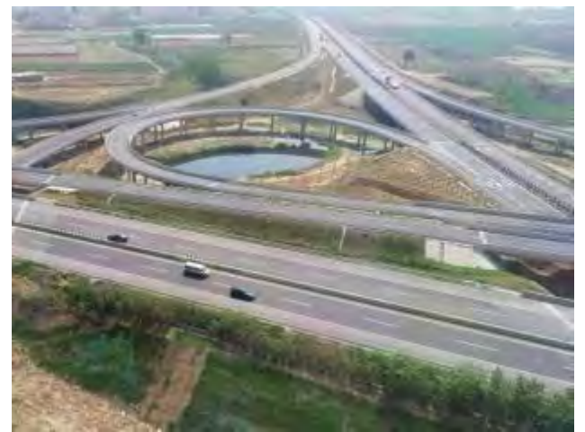
照片 18 前草岗互通立交
