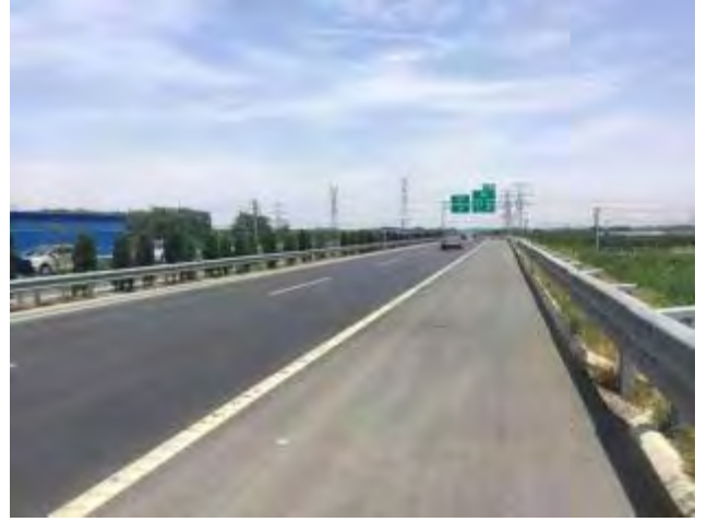
照片 2 路基工程区路面情况
