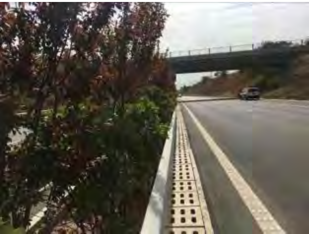
照片 5 路基排水沟
