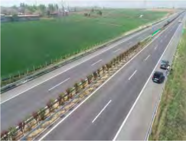
照片 1 路基工程区路面情况
