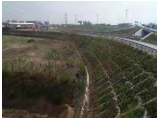
照片 20 互通立交拱形骨架护坡
