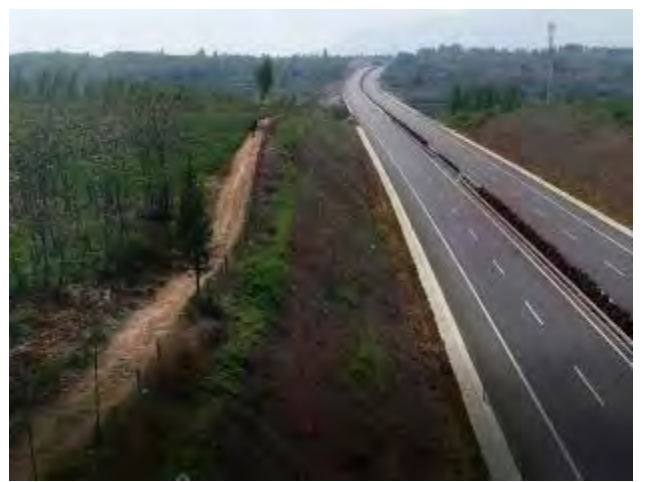
照片 12 路基边坡挂网防护
