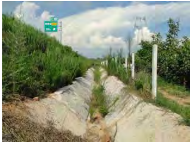
照片 6 路基排水沟
