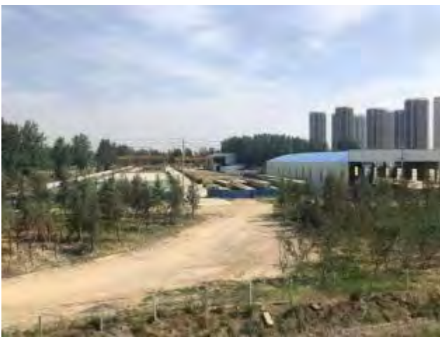
照片 29 1标梁场钢筋场（已交还，现当地利用）
