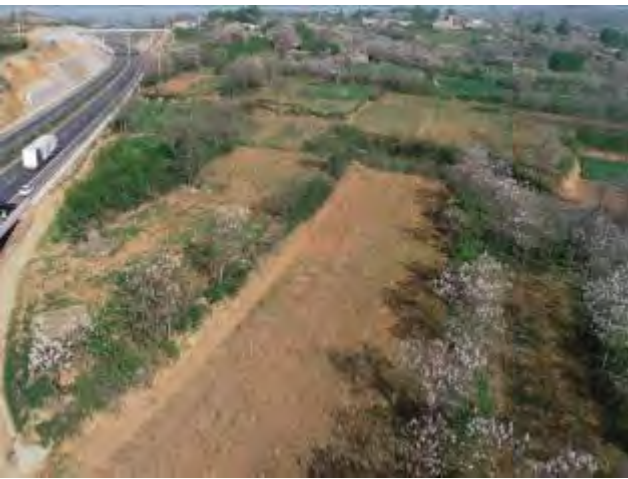
照片 39 7 标钢筋厂（已覆耕）
