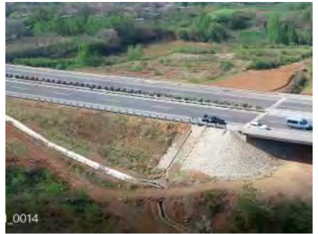
照片 16 桥头防护
