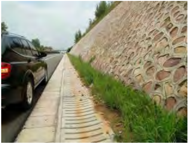
照片 3 路基排水沟
