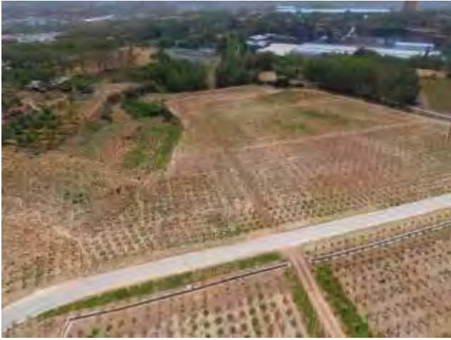
照片 43 NO.3 号弃渣场
