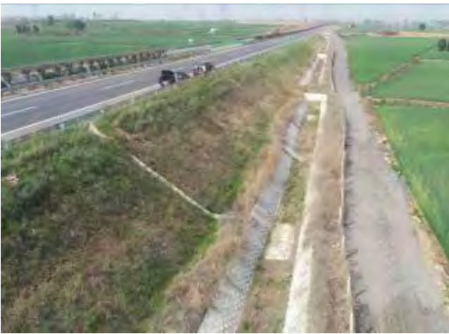
照片 9 路基边坡喷播植草灌绿化
