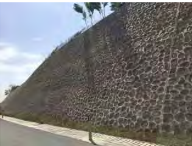
照片 11 路基边坡防护
