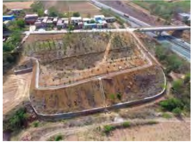
照片 44 NO.4 号弃渣场
