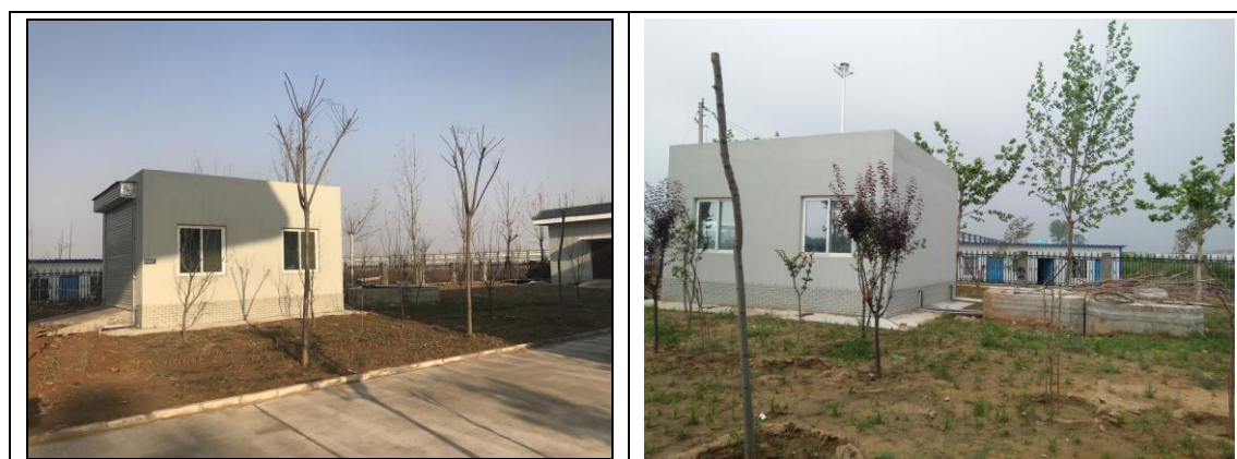
图 7.2-8 收费站污水处理系统
