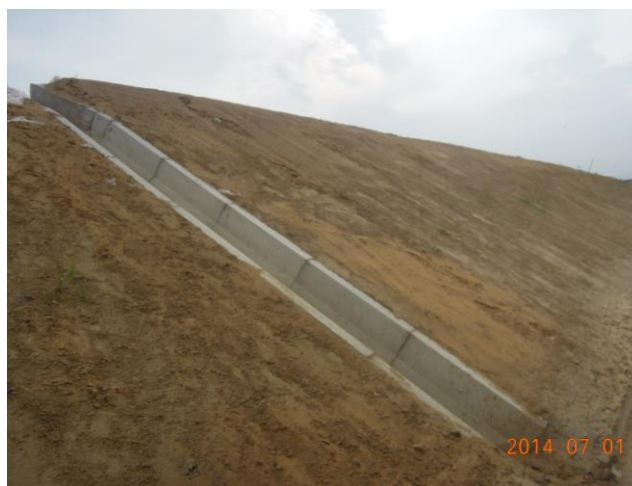
图 7.1-1 临时排水设施
