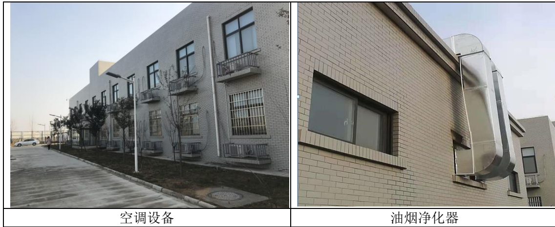
图 8.1-2 空气防治措施照片
