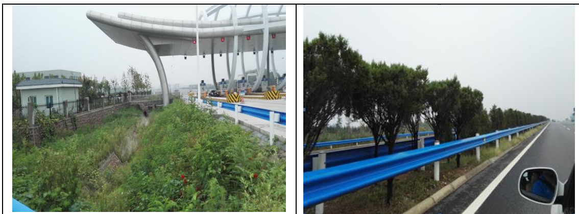
图 5.2-2 绿化措施现场照片
